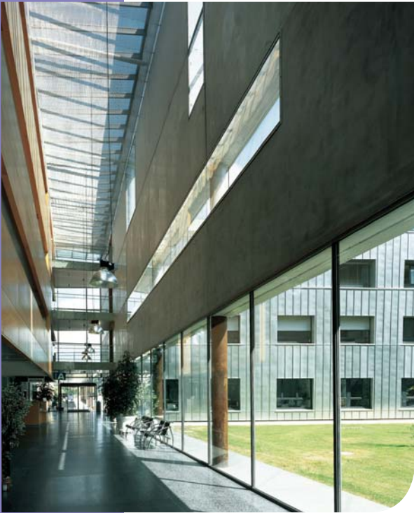
Centra Hospitalier Intercommunal du Val d' Ariege - France
